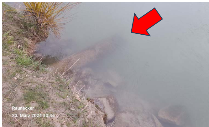
Bild 12: Einleitungsstelle Innkanal (roter Pfeil)
