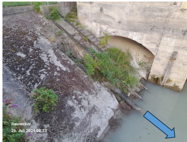
Bild 7: Auslaufbauwerk in den Unterlauf Kraftwerk
