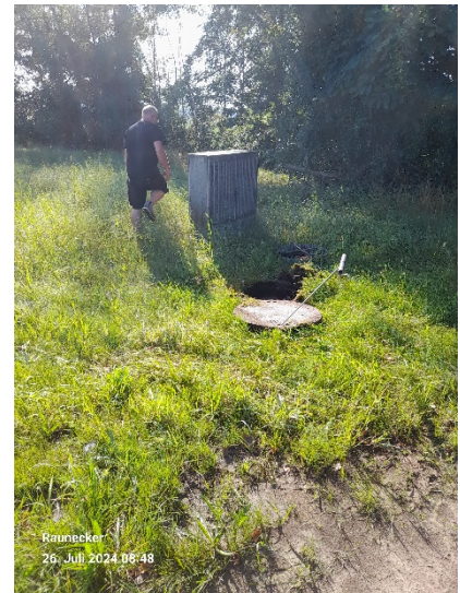
Bild 4: Zugang zum Bauwerk
