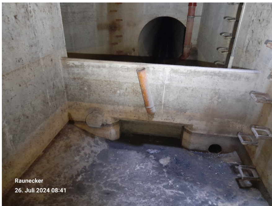
Bild 9: Spülkammer, außer Betrieb
