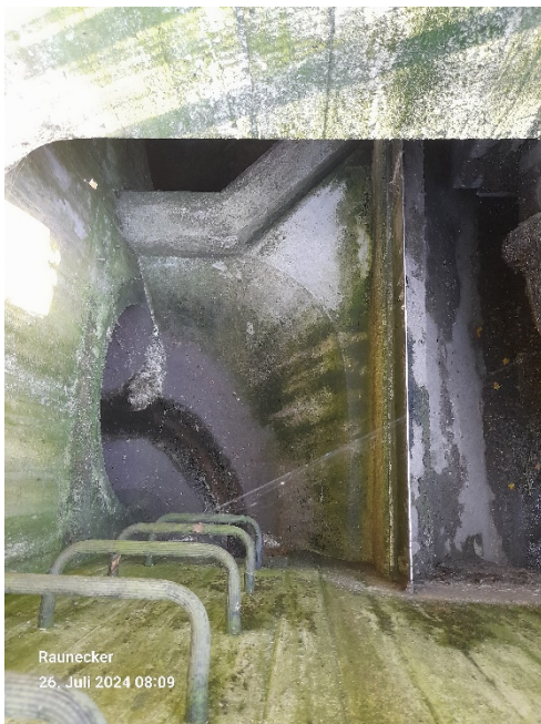
Bild 11: Blick in das Trennbauwerk
