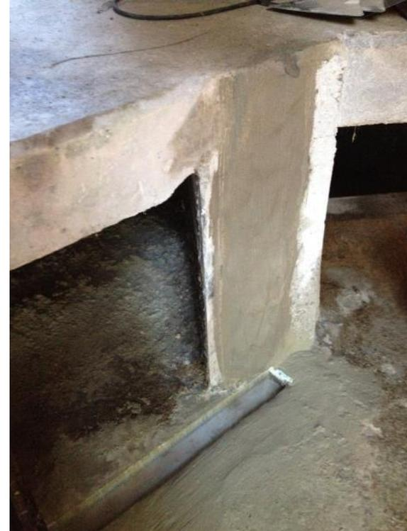
**22.09.2014: Die neue Zwischendecke und das U-Profil für den Rechen sind fertig.**
