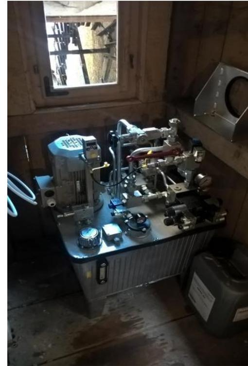
**Die hydraulischen Anlagen zur Steuerung der Schützen werden installiert.**
