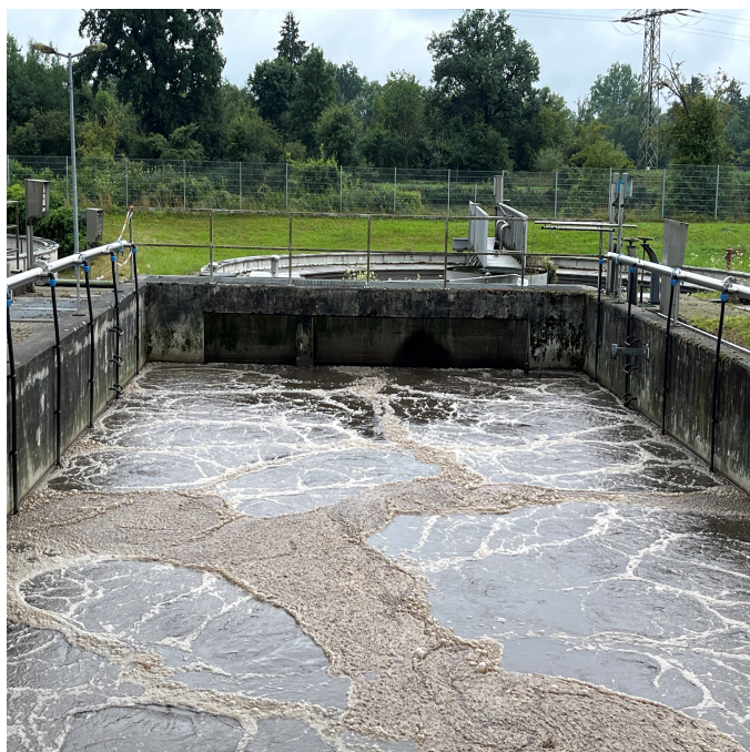
Abbildung 5: Ansicht Belebungsbecken 1.2, Kläranlage Töging
