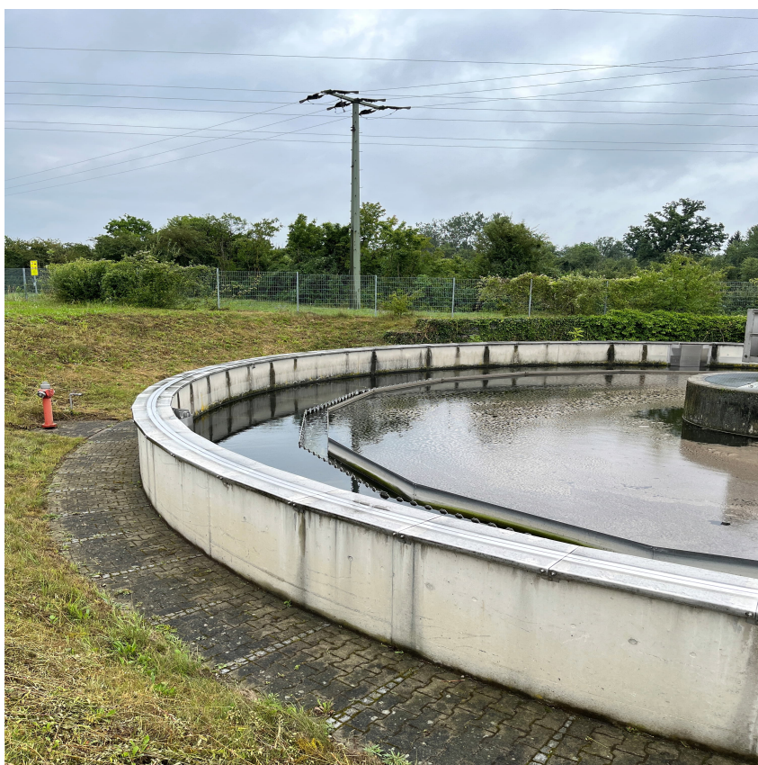
Abbildung 6: Ansicht Nachklärbecken 2, Kläranlage Töging
