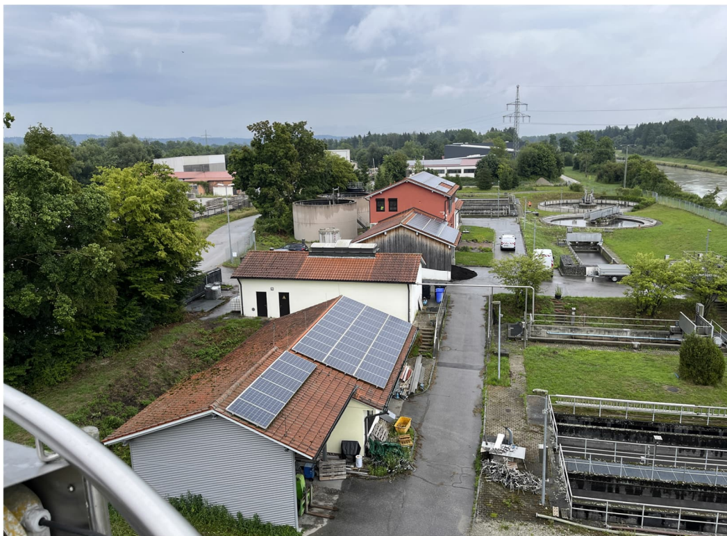
Abb. 5: Foto 30.07.2025, Blick über die Kläranlage nach Osten
