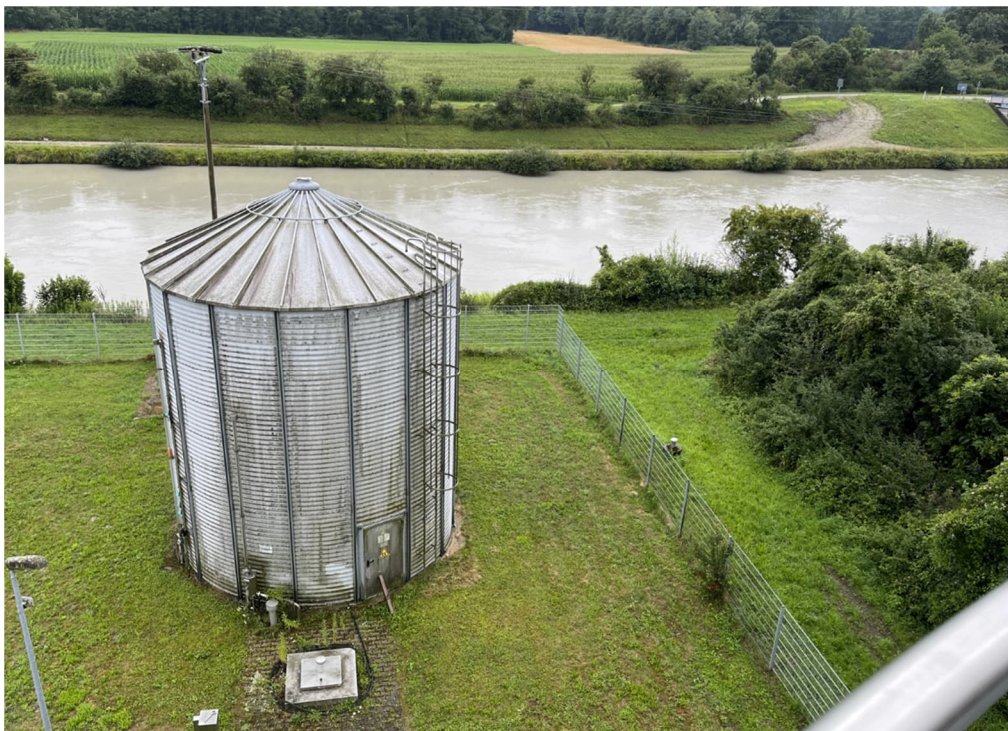
Abb. 6: Foto 30.07.2025, Blick nach Süden zum Innwerkkanal
