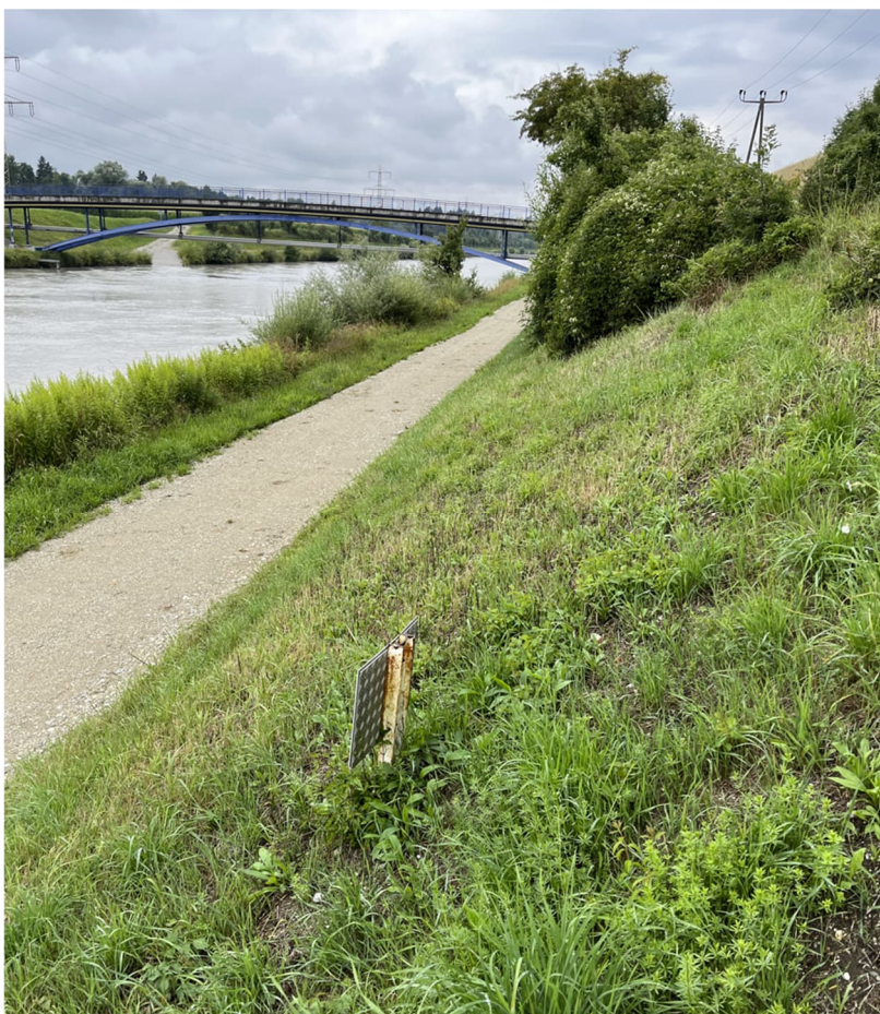
Abb. 7: Foto 30.07.2025, Blick auf die Böschung zum Innwerkkanal
