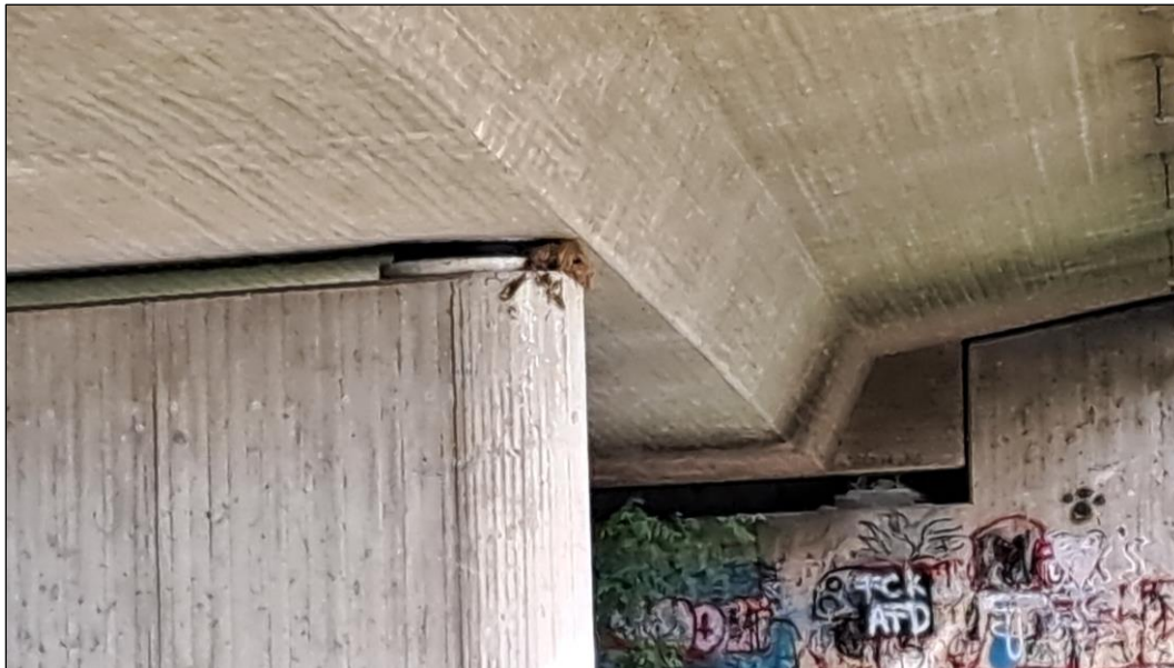
Abb. 3 Wasseramselnest auf Brückenpfeiler
