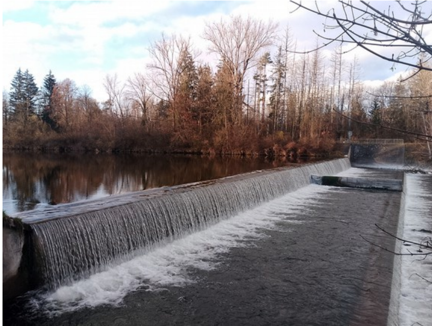
Abbildung 6: Absturz Walder Stützschwelle 2024.
