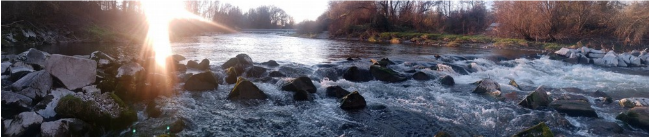
Abbildung 1: Rampenbauwerk unterhalb der Walder Stützschwelle - 2024.
